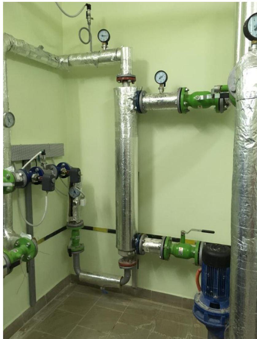
Рис. 2.3. Элементы схемы ИТП на базе кожухотрубных теплообменных аппаратов
